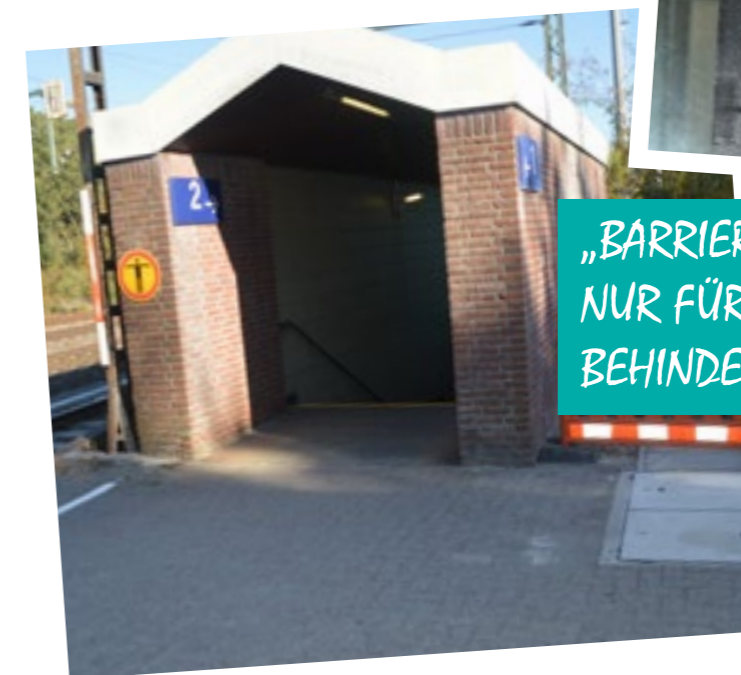
KAUM ÜBERWINDBARE HÜRDEN: Am Bahnhof Lemförde fehlt es komplett an Aufzügen.
