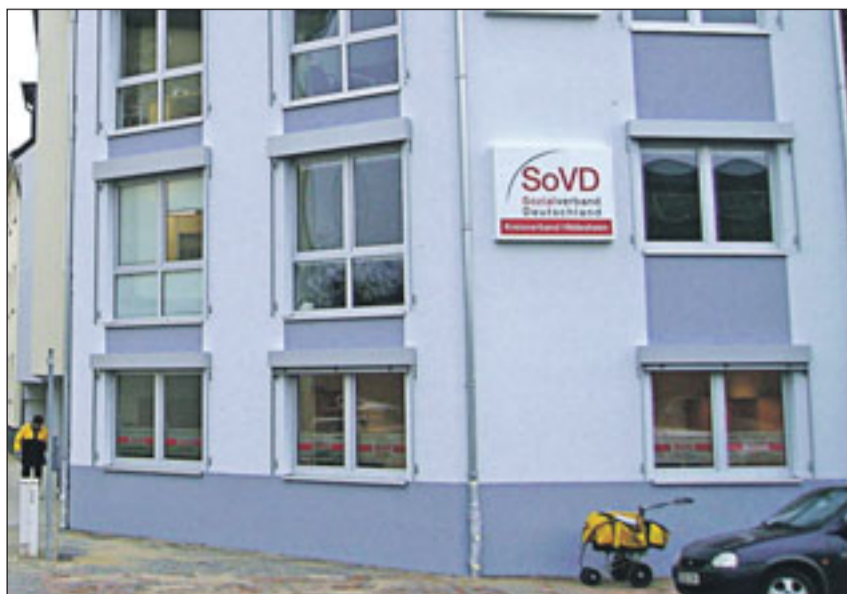
Die neue Geschäftsstelle in Hildesheim ist einem Neubau in der Oststadt untergebracht.
