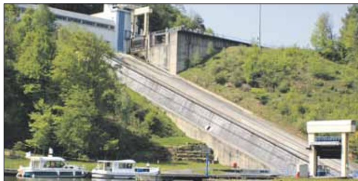
Der Ortsverband besichtigte das Schiffshebewerk Arzviller.
