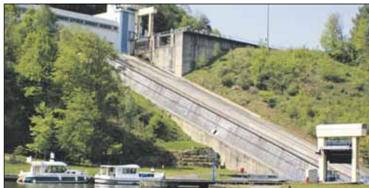
Der Ortsverband besichtigte das Schiffshebewerk Arzviller.
