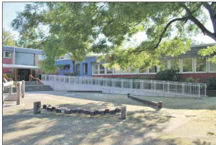
Endlich ist die Rampe da, die es auch Rollstuhlfahrern erlaubt, in die Staudinger Grundschule zu gelangen.
